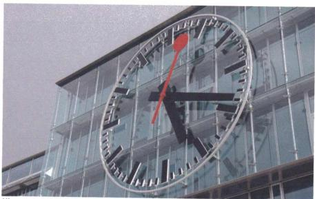
Mit neuen Metern Durchmesser ist die Uhr am Bahnhof Aarau die grösste von Moser-Baer gebaute SBB-Bahnhofsuhr.
